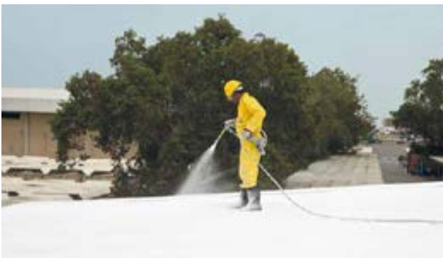
图 2 : 陶氏化学进行反射屋顶的涂覆
