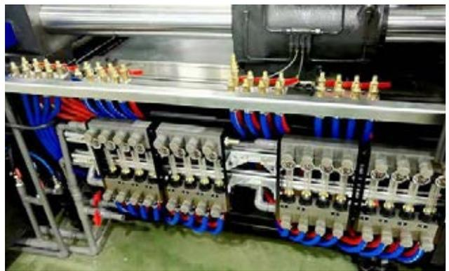
图 6：冷却水的流量监控(速利达公司提供)
